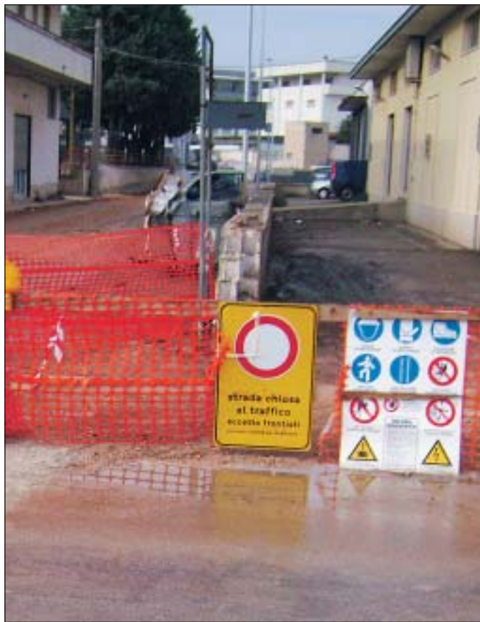
DISASTRATA La zona industriale in pessime condizioni
